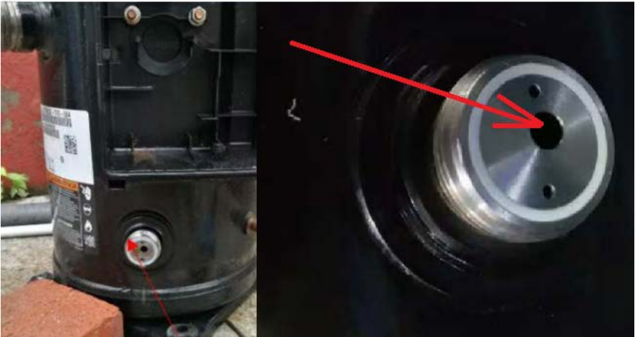
ZFI150系列压缩机的挡油板
